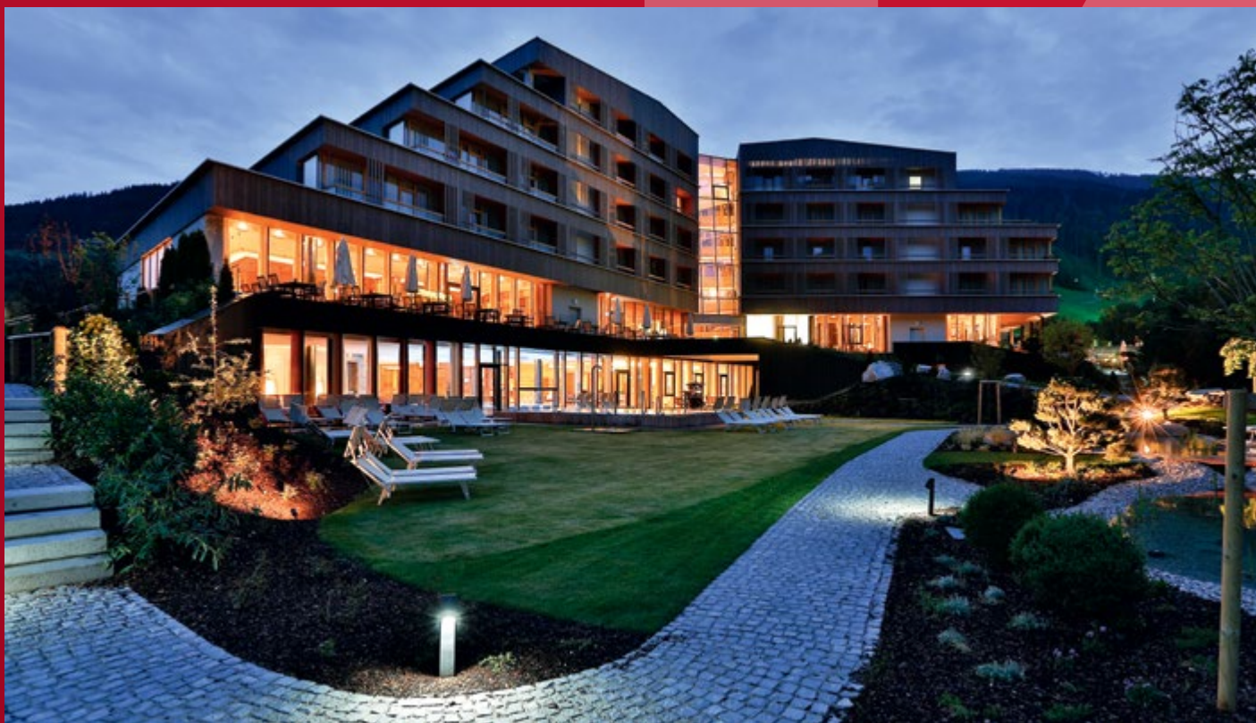
Готель «Falkensteiner Hotel Schladming» Шладмінг, Австрія
